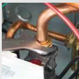
Rimozione del sistema di serraggio della tubazione
