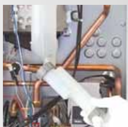
Rimozione sifone condensa
