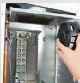
Rimozione del sistema di combustione completo
