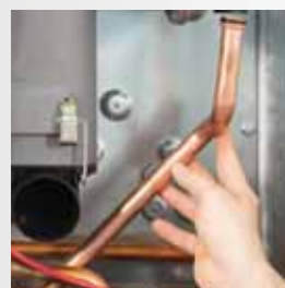
Rimozione del tubo gas
