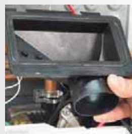
Ispezione raccolta condensa
