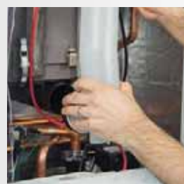
Rimozione collettore fumi
