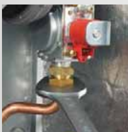
Rimozione del sistema di serraggio sulla valvola gas
